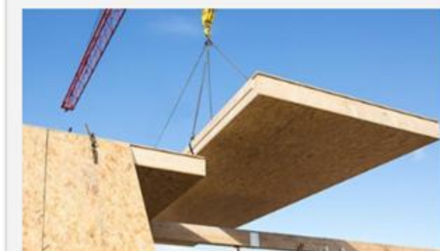
Linzmeier Fertigelemente werden positioniert
